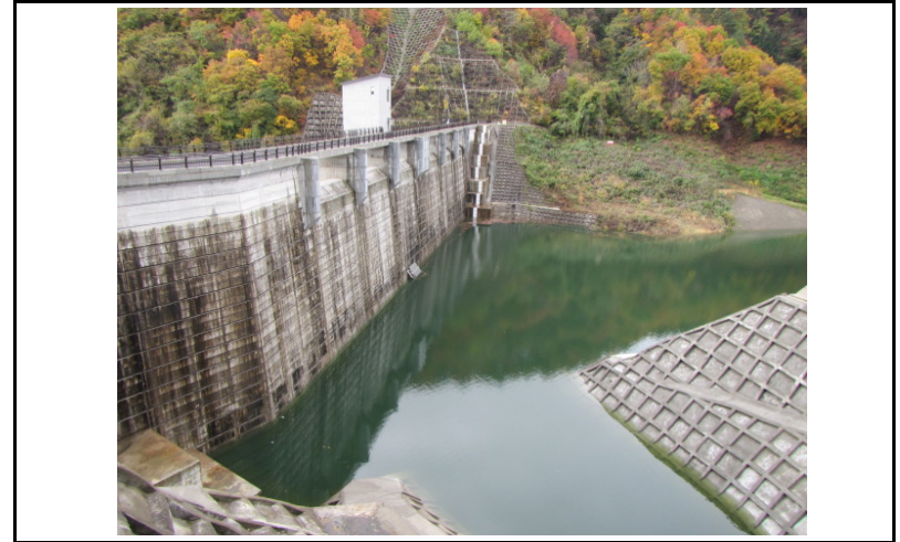
2 ダム上流面(左岸から)
