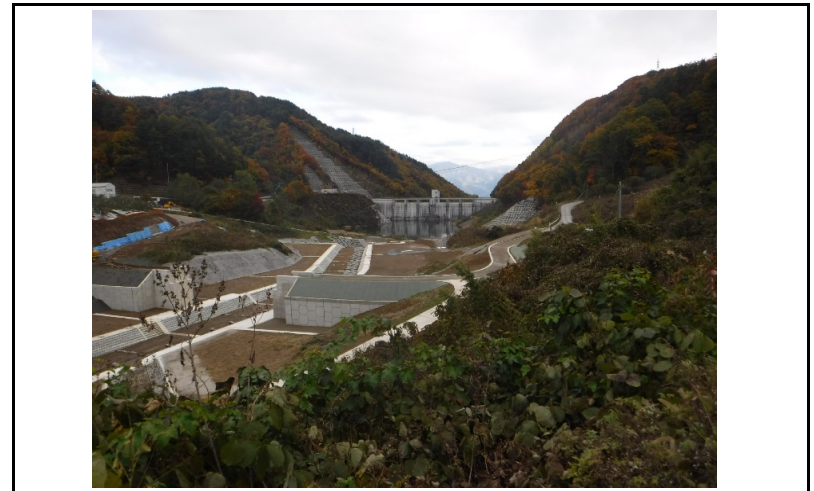
4 貯水池(上流からの全景)
