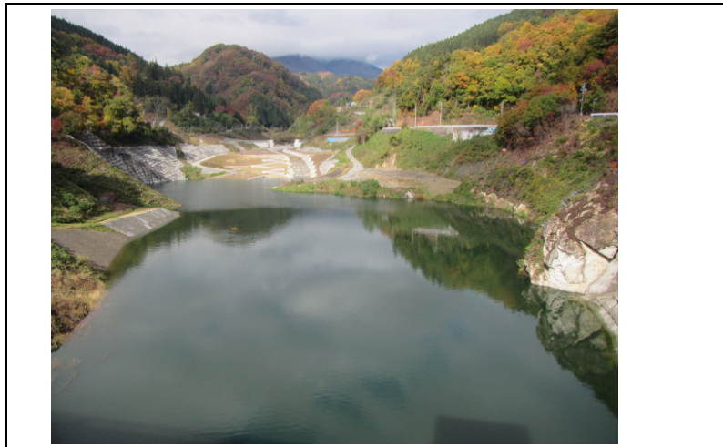
3 貯水池(ダムから上流)
